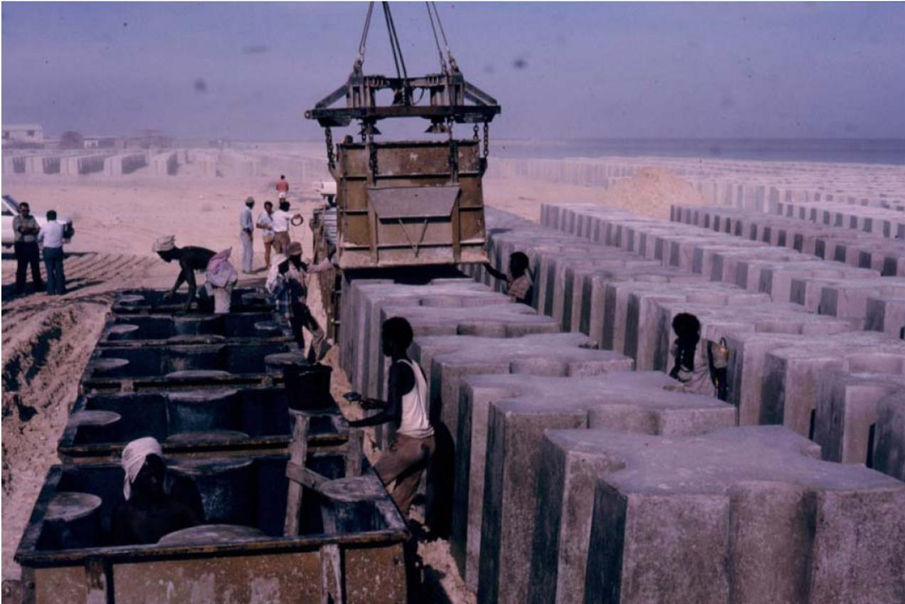
*Fig. 5: Realizzazione blocchi Antifer – Bosaso*
